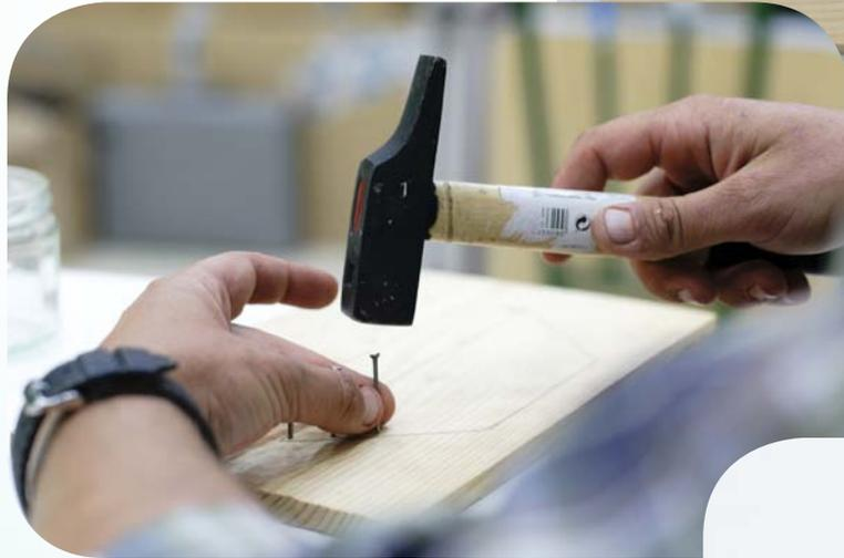
**5.** Clava unos clavos alrededor del trapecio dibujado dejando la parte superior libre. Con unos 15 ó 20 clavos será suficiente para soportar el peso de la estructura.
